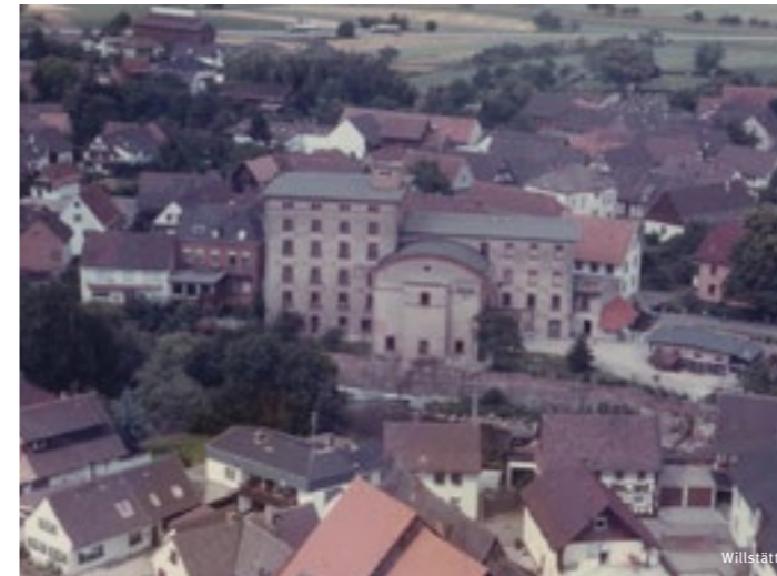
Avant la rénovation : le bâtiment du moulin vétuste ainsi que l'espace extérieur inutilisé.
