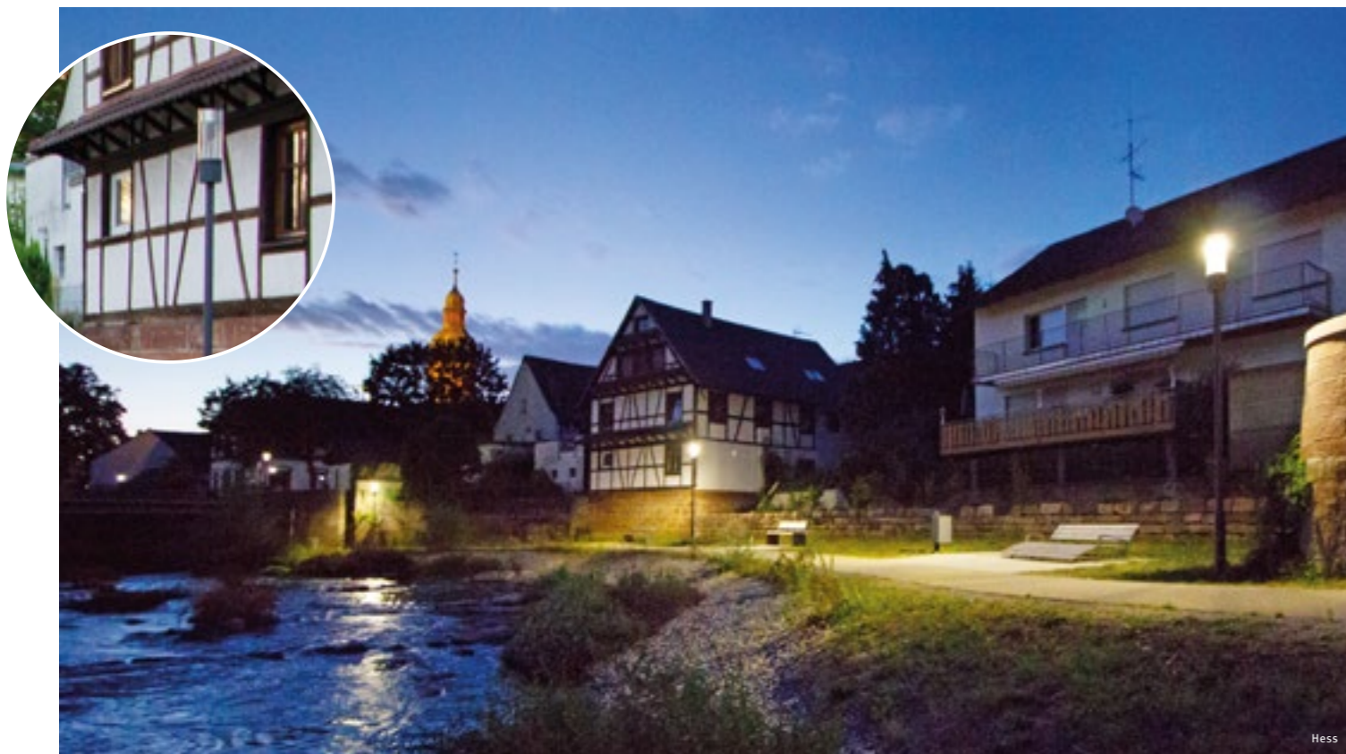
Des luminaires élégants RESIDENZA créent une atmosphère très agréable le long de la rive pendant la soirée et la nuit.
