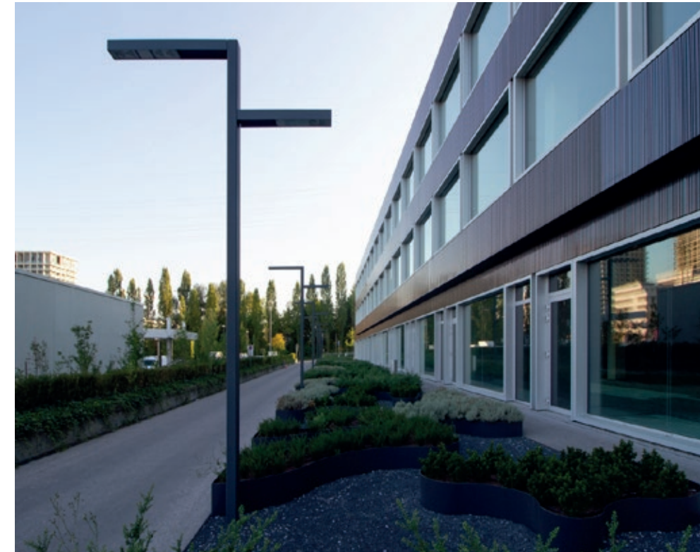
Des têtes de luminaire décalées assurent un éclairage uniforme du chemin piétonnier et des espaces verts.
