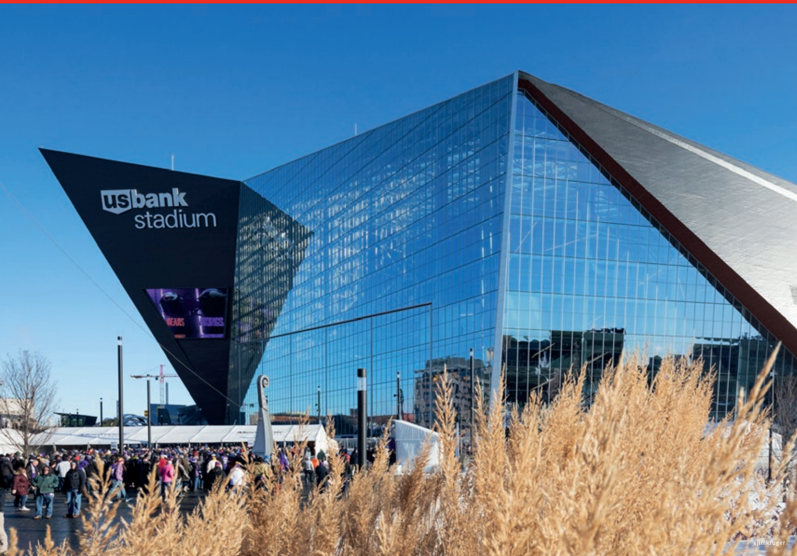
Impressionnant sur le plan architectural : le stade « U.S. Bank Stadium » avec son immense façade en verre attire les visiteurs du monde entier, comme par magie. Les colonnes lumineuses multifonctionnelles CITY ELEMENTS de Hess s'intègrent discrètement dans l'espace extérieur.
