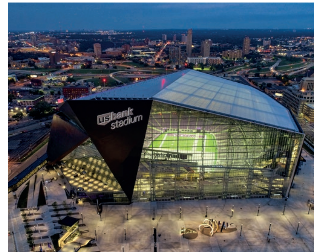
Un bâtiment imposant : la façade en verre et le toit, composé pour la plus grande partie d'un film, inondent le stade de lumière. L'espace extérieur est bordé de CITY ELEMENTS 230 en différentes hauteurs.
