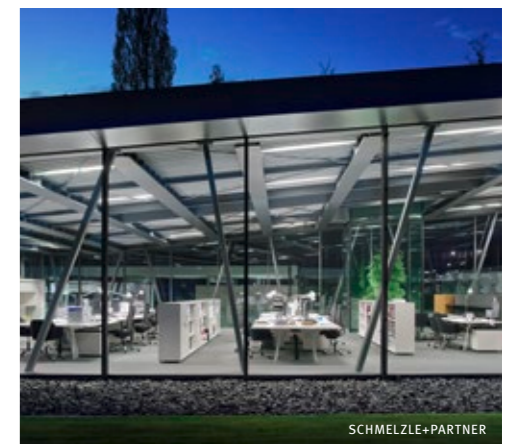
Des piliers en diagonale suppriment d'autres croisements dans la structure métallique.
