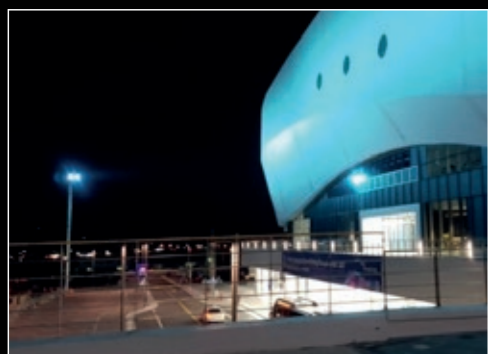
Les puissants projecteurs assurent une distribution homogène de l'éclairage sur la façade.
